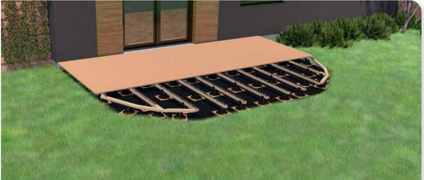
Kanthölzer für die Rundung anbringen
