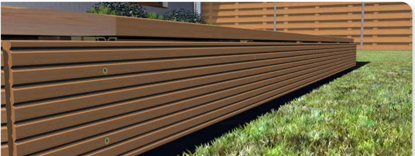
Dielen an senkrechte Profile schrauben
