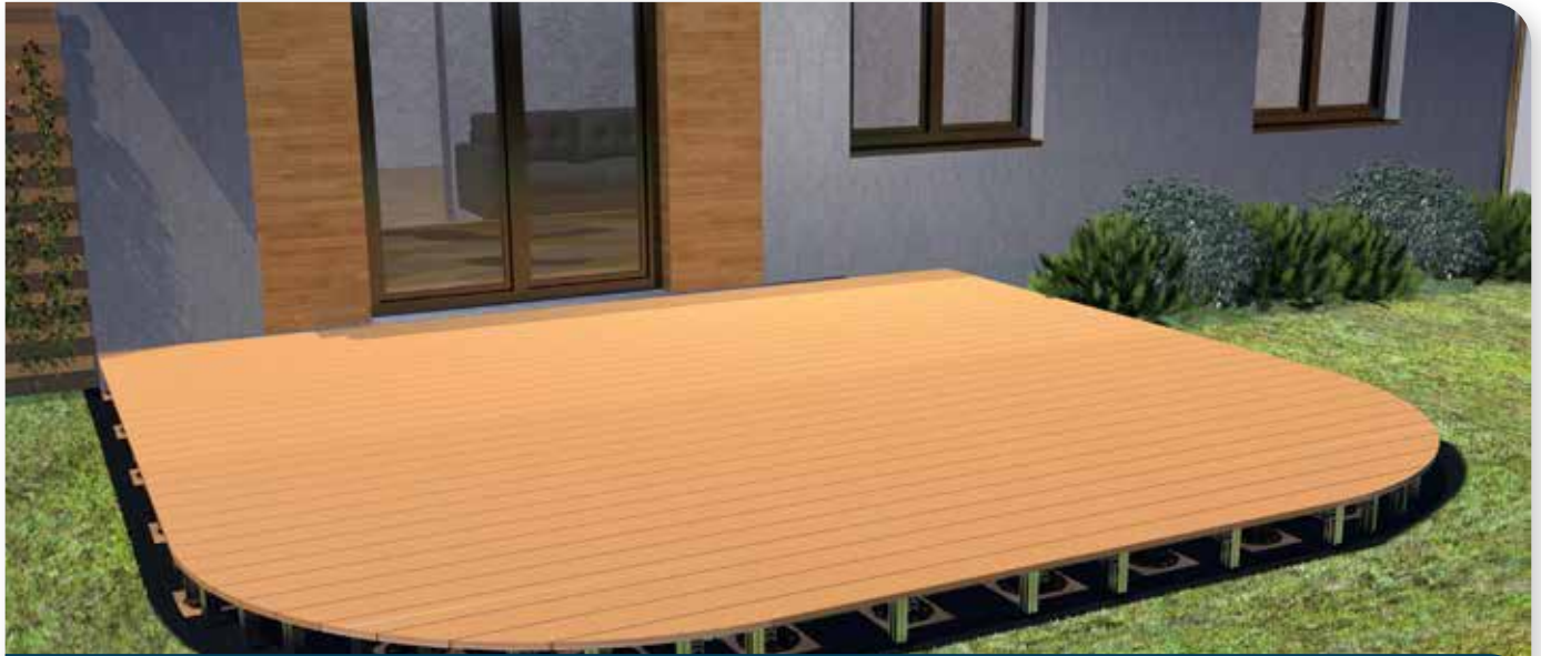
Dielen für die Lauffläche anbringen
